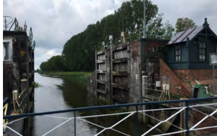
Écluse antique à Zoutkamp
